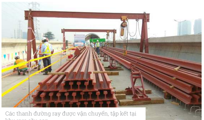
Cứ 200m đường ray được hàn lại với nhau, sau đó được đặt lên tà vẹt và đổ bê tông.
