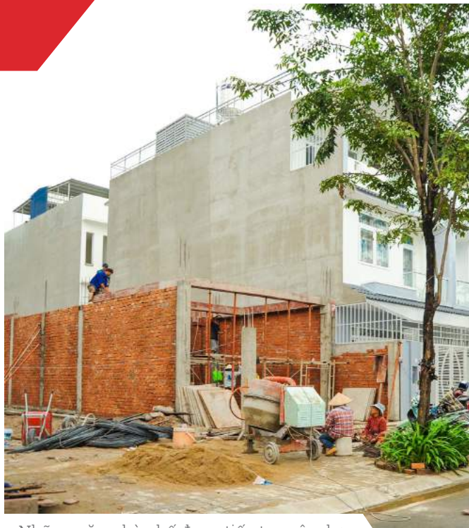
Những căn nhà phố đang tiếp tục xây dựng
