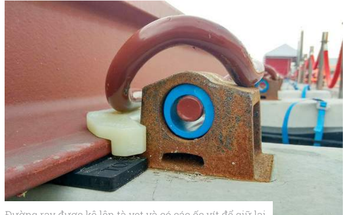
Đường ray được kê lên tà vẹt và có các ốc vít để giữ lại
